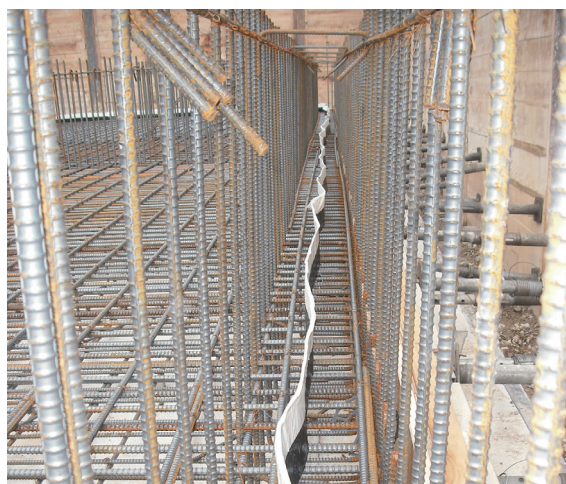
置き施工(左右鉄筋へ交互に結束線で固定)
