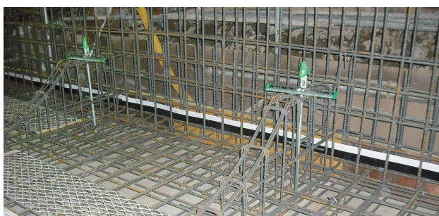
吊るし施工(コン天が止水板中央にくる位置に設置)
